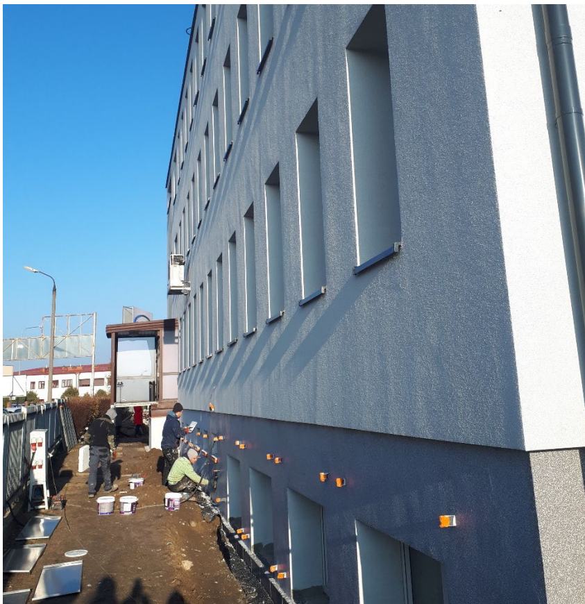
Elewacja - prace wykończeniowe
