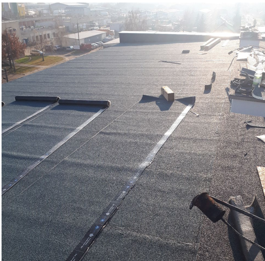
Układanie papy na dachu
